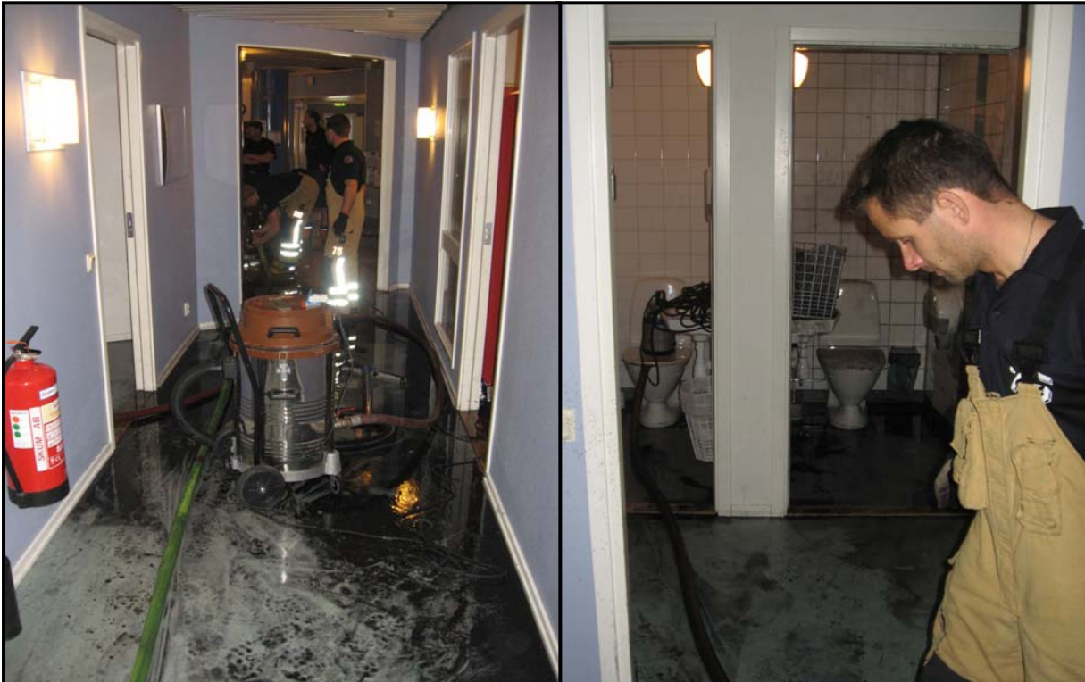
Bild 2 & 3. Vattendammsugning och annat restvärdearbete av räddningstjänsten
