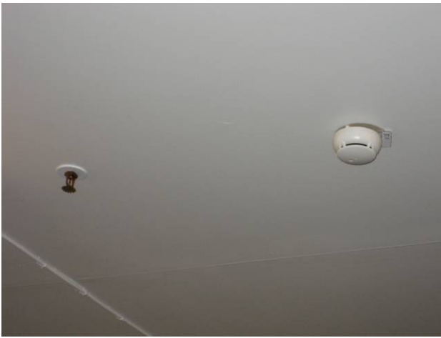
Bild 3. Sprinkler. & rökdetektorsystem
