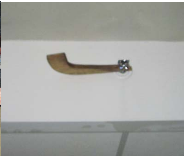
Bild 4 Träkil i sprinklerhuvud (tyvärr oskarp)
