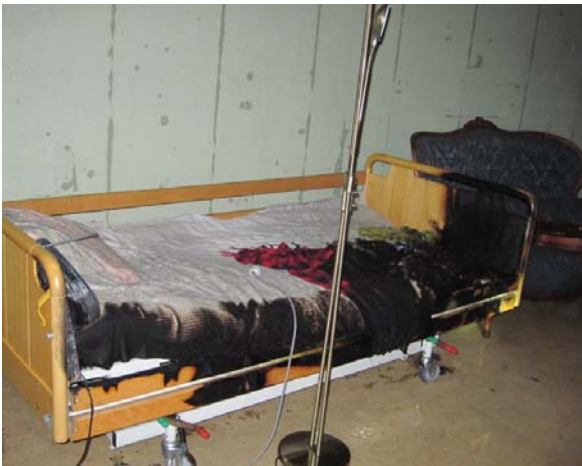
Bild 1 Brandskadad säng & halogenlampan
