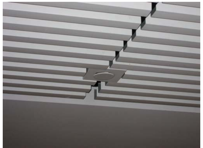
Bild 3. Concealed sprinkler
