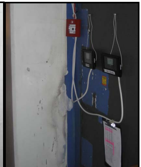
Bild 5: Brandskadat hörn
