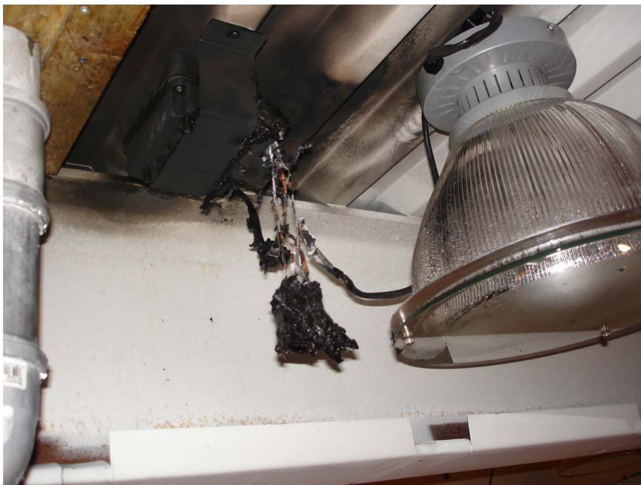
Bild 2: Resterna av den ”svarta plastlådan” som tänder/släcker belysningsarmaturen (foto Per R)
