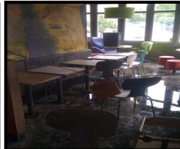
Bild 6. Rök-, sot- & vattenskador
