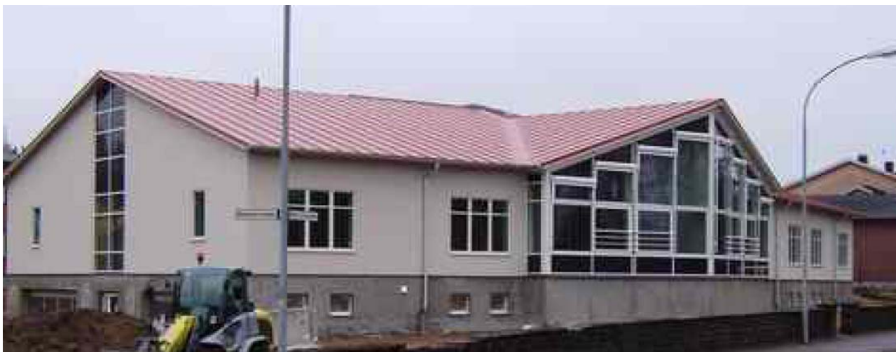
Bild 2. Byggnad med källarplan där brandincidenten inträffade
