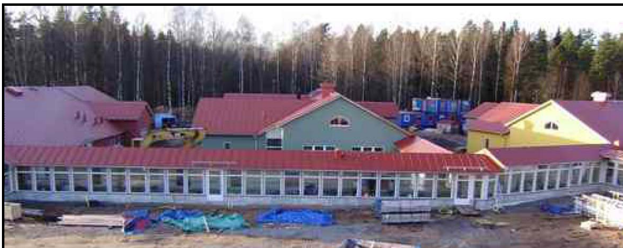
Bild 1. Vy över hela byggnadsområdet för det nya Demenscentrum i Gislaved
