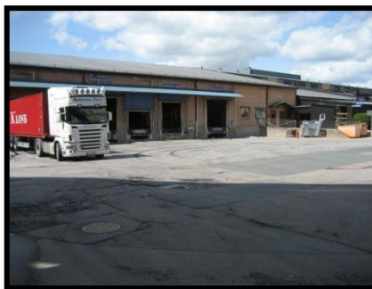
Bild 3. Centralförrådet till höger
