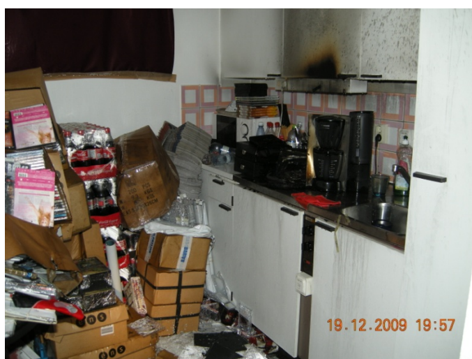
Bild 1 visar att branden startat i anslutning till spisen.
