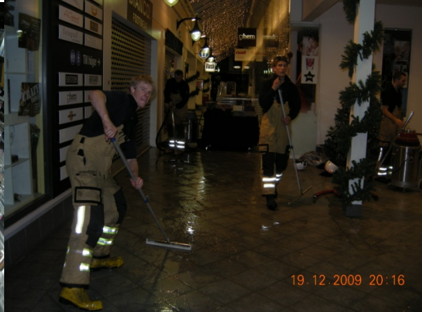
Bild 3 Visar den öppna planlösningen i Knallerian. På bilden pågår saneringsarbete.
